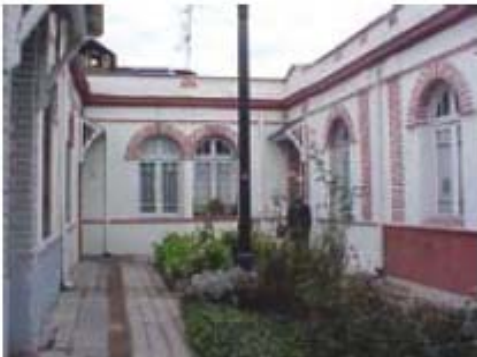
Foto 3.8 Vista interior del cité desde la calle. Se observan los detalles decorativos hechos con ladrillo y estucos. Fuente: Foto C. Gutiérrez
